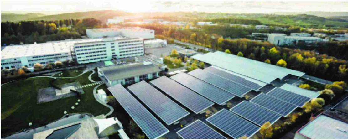
Die Duitse ingenieursgroep ABB se fabriek in Duitsland wat elektrisiteit kry van 'n sonkrag-en-batterystelsel.
