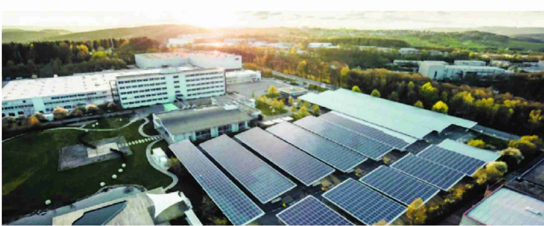
Die Duitse ingenieursgroep ABB se fabriek in Duitsland wat elektrisiteit kry van 'n sonkrag-en-batterystelsel.
